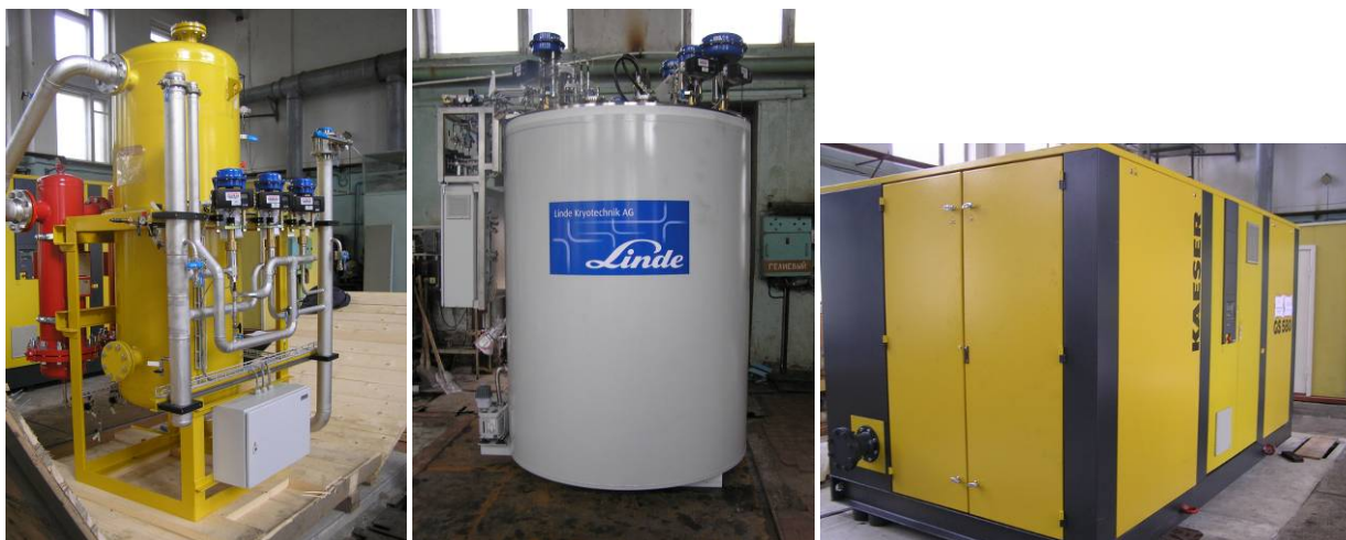
Рис. 2. Начало монтажа криорефрижератора.
